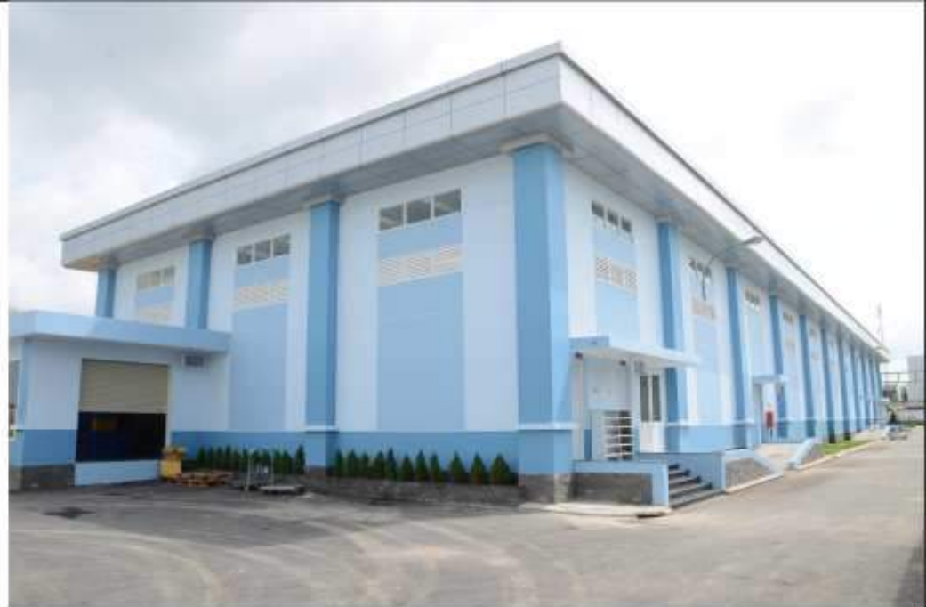
Nhà máy nang mềm (xưởng 4) hoàn thành và bắt đầu hoạt động tháng 5/2011
